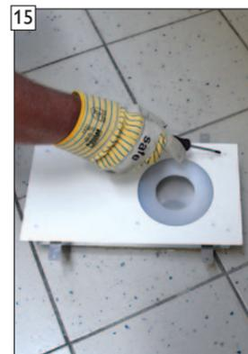
15 Befestigungsschrauben der LAS Zuluft-Adapterblende entfernen.
