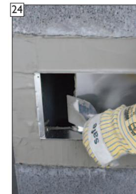
24 Übergang an der Mantelsteinzunge dicht mit Mörtel anschließen.
