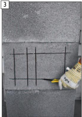
Mit der Dämmstoffsäge Dämmung entlang der Schnittkante aufschneiden.
