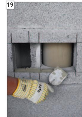
19 Bauseitigen Mörtel MG (M5) IIa (Mauermörtel nach EN 998-2) in die Öffnung des Mantelsteins auftragen.
