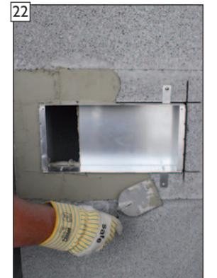
22 Rahmen umlaufend mit bauseitigem Mörtel MG (M5) IIa (Mauermörtel nach EN 998-2) dicht einmörteln.
